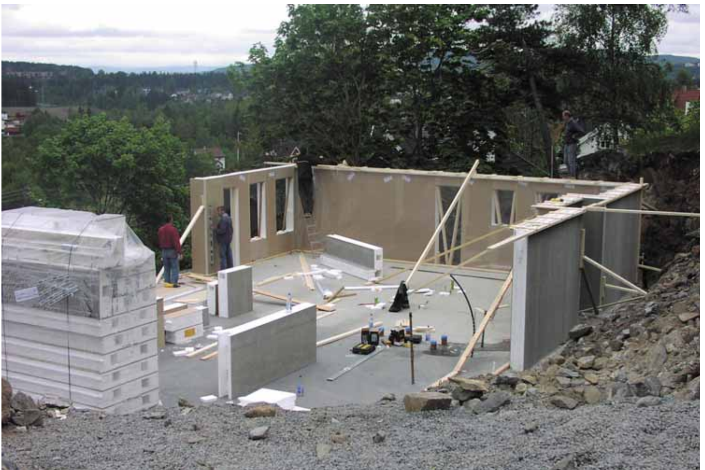
Ferdige dør- og vindusåpninger
