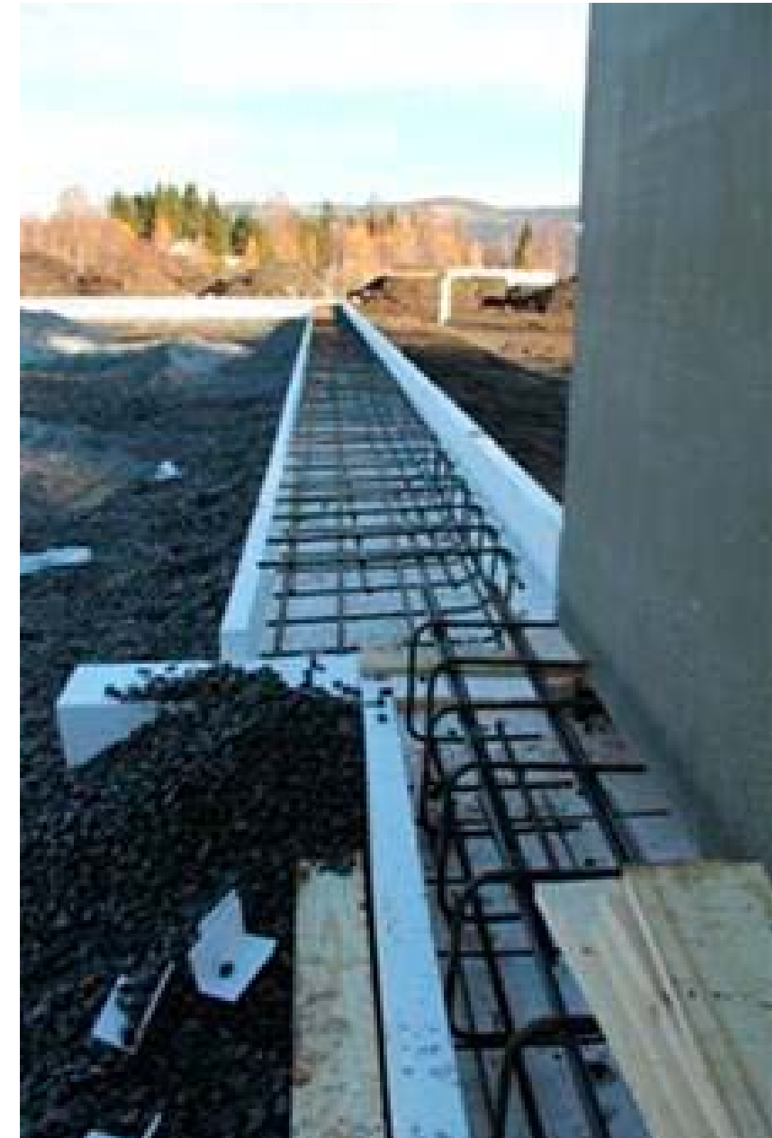
Søyelfundament tilpasset store laster
