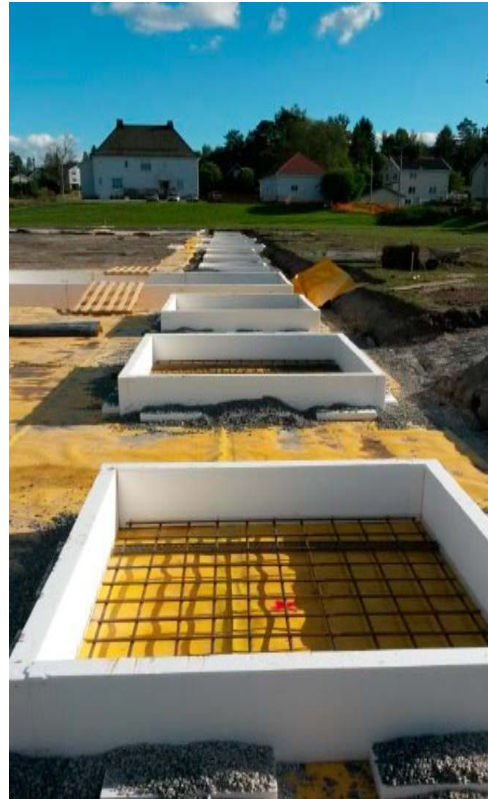
Søyelfundament tilpasset store laster
