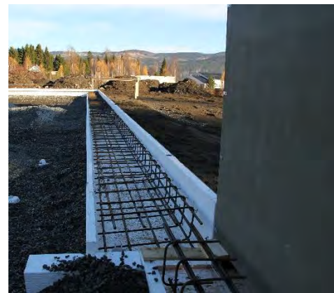
Såler tilpasset store laster
