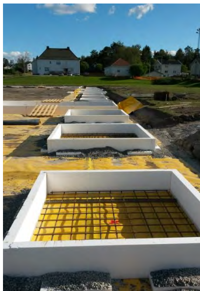
Søylefundamenter tilpasset store laster
