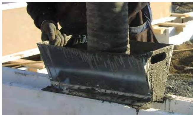
Støpekasse gir trygg støp
