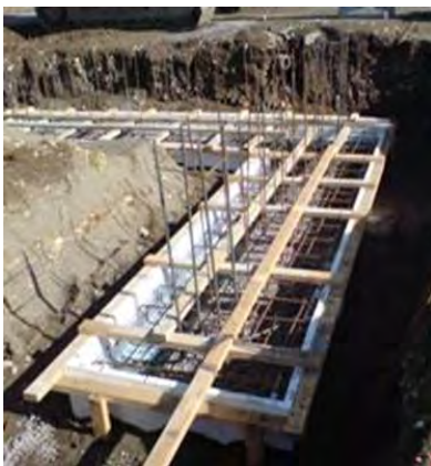
Såler tilpasset store laster
