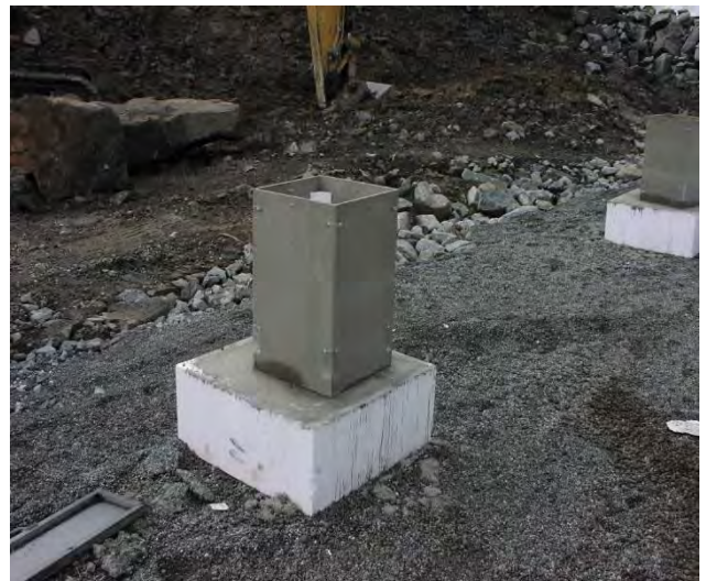
Søylefundament med søyleforskaling
